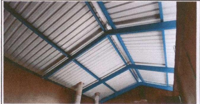
Foto 2: Sustitución de soporte de madera, por metal
